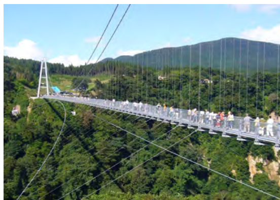
九重“夢”大吊橋
